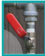
✓ votre sortie d'eau extérieure ne doit pas être équipée d'une valve anti-retour. Si c'est le cas, elle devra être modifiée avant la pose du réseau temporaire.
